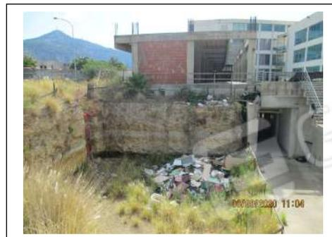
**Foto 90.** Scavo di sbancamento del prolungamento dell'edificio in corso in costruzione
