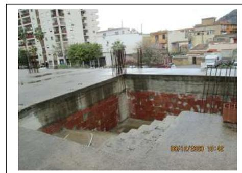
**Foto 79.** Edificio in corso di costruzione. Estradosso del solaio del piano terra e corpo scala
