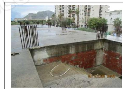
**Foto 81.** Edificio in corso di costruzione. Estradosso del solaio del piano terra e corpo scala
