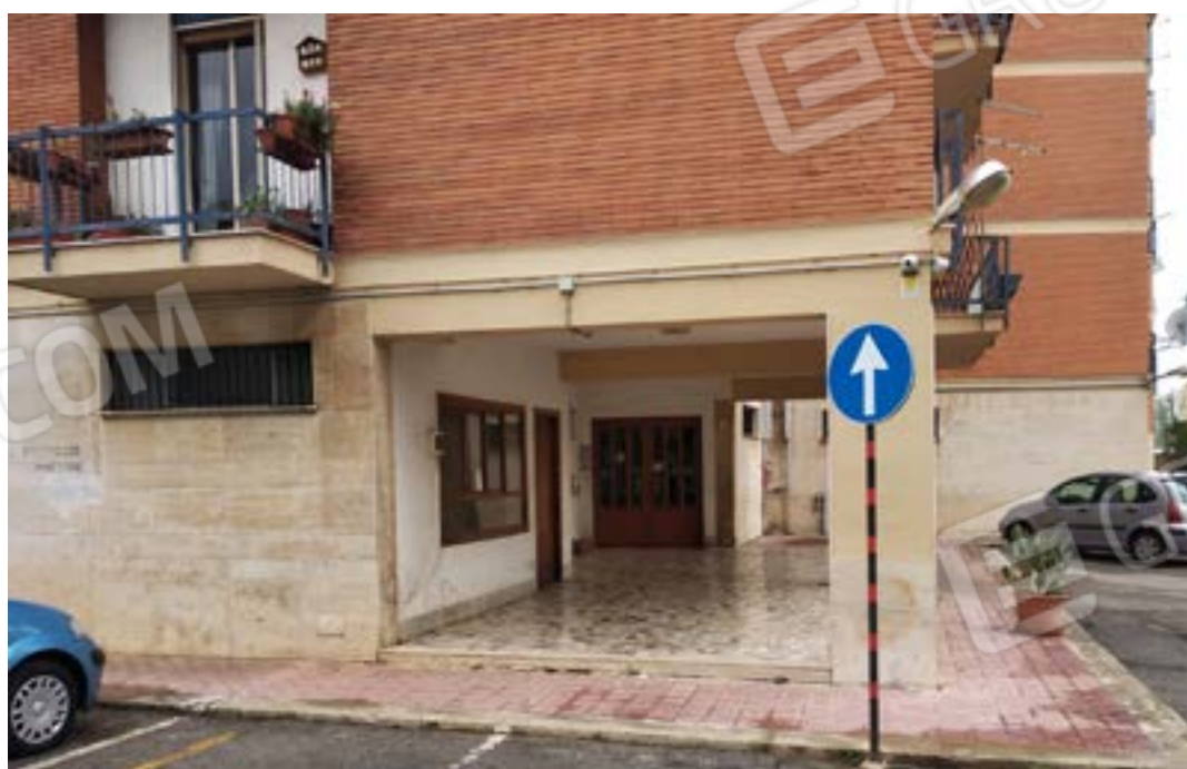
FOTO n. 2 - Ingresso alla palazzina "B"
