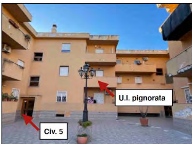
Prospetto sulla corte comune - Civ.5
