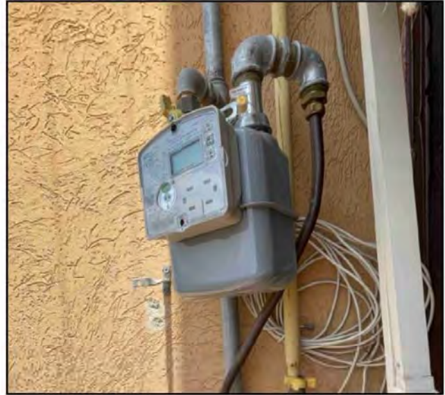
Contatore del gas
