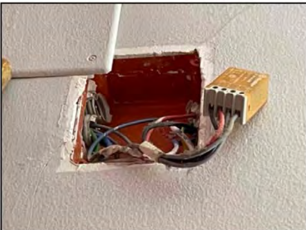
Interno di una cassetta di derivazione
