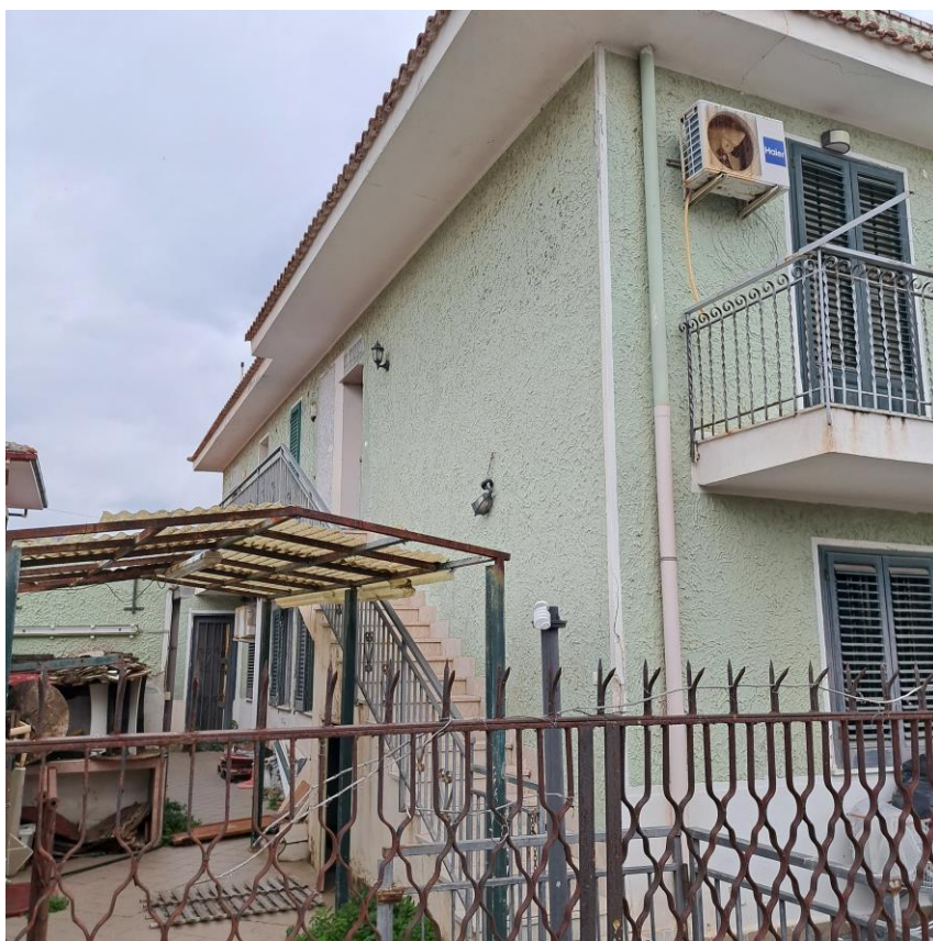
Retro prospetto e ingresso sub 2
