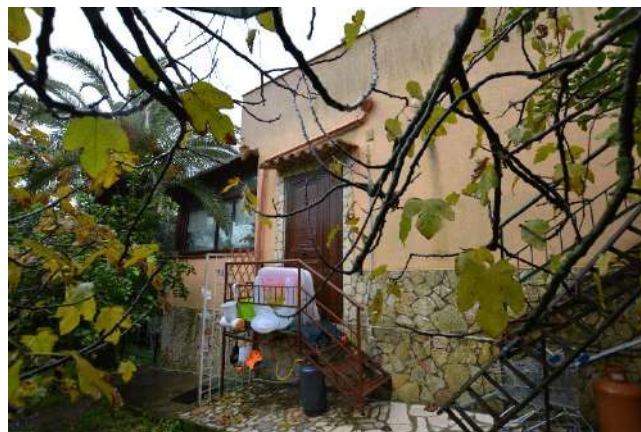
Foto 22 (Allegato 9) Secondo ingresso su portico
