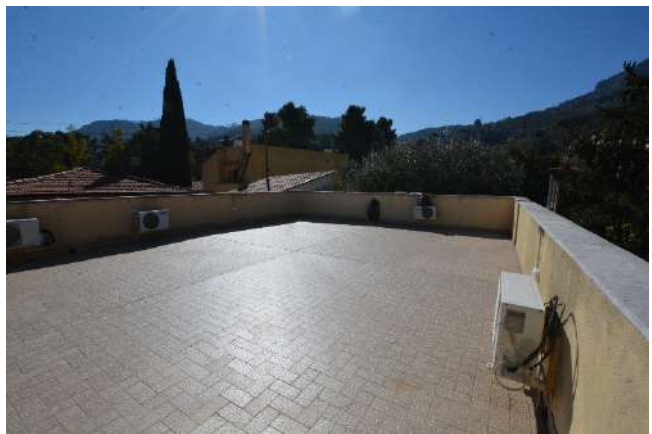
Foto 26 (Allegato 9) Lastrico solare di 1° piano – Fig. 5, p.lla 517, sub.3
