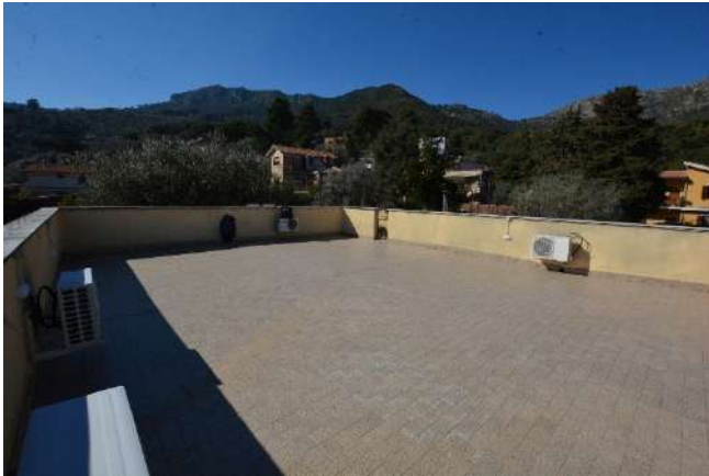
Foto 25 (Allegato 9) Lastrico solare di 1° piano – Fig. 5, p.lla 517, sub.3
