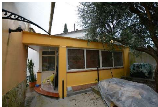
Foto 18 (Allegato 9) Locale di sgombero
