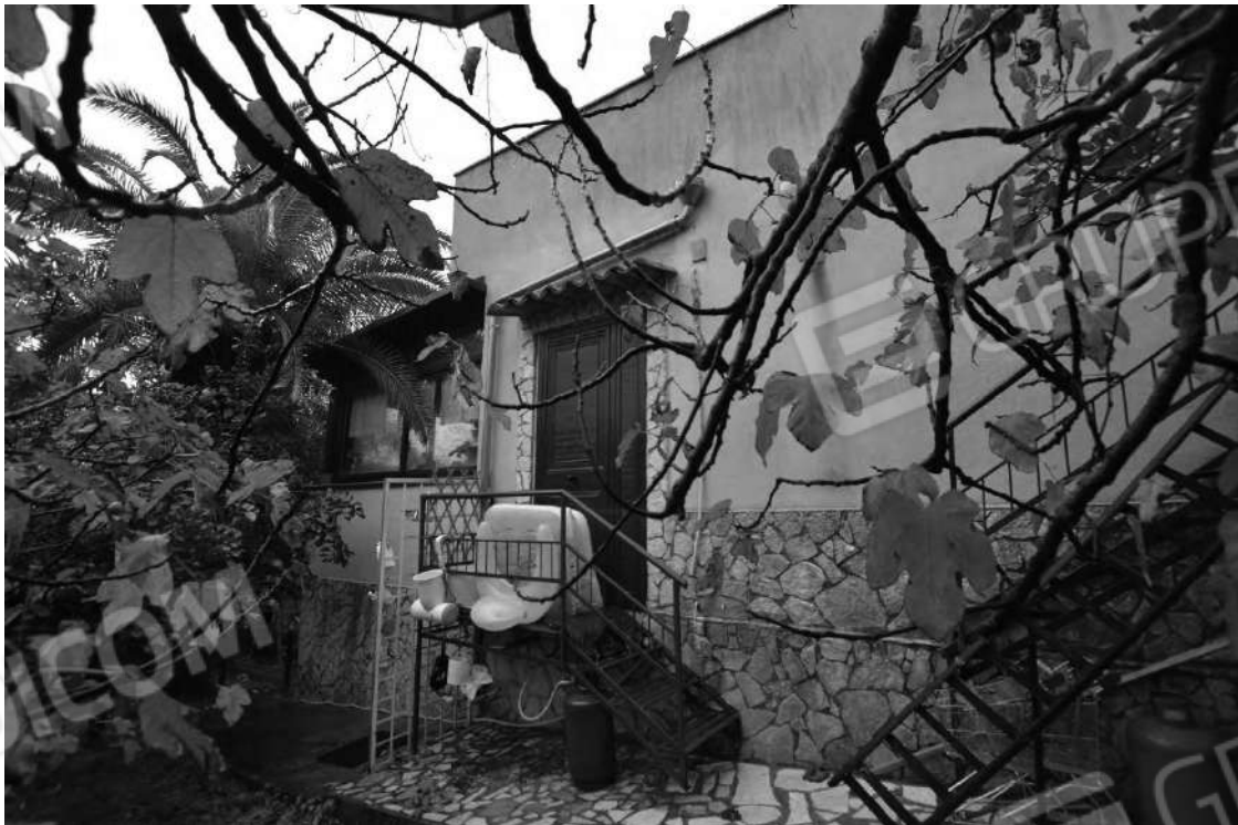
Foto 21 – u.i “A.” – Ripostiglio sotto il portico della villetta di Via SM 14 n. 4
