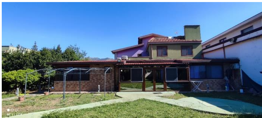
Foto -16- Prospetto posteriore, in primo piano il portico chiuso al piano terra
