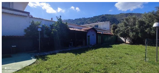
Foto -14- Locali tecnici, w.c., magazzino, barbecue
