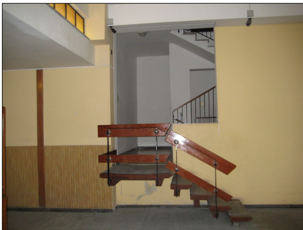
Vista della scala B
