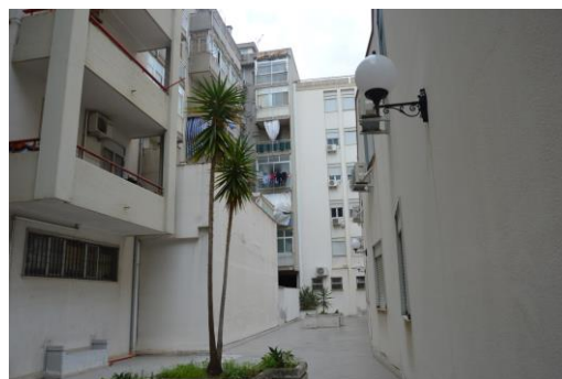
Foto n. 2 Area esterna condominiale
