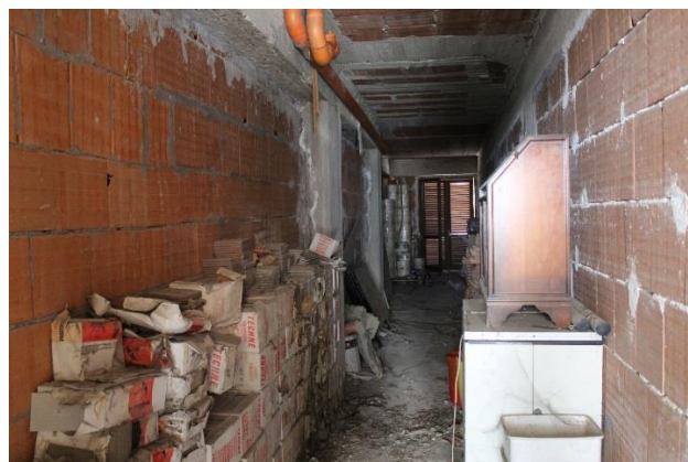
Vista verso l'apertura su via Mazzini
