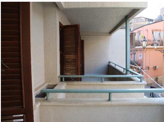
Vista di un balcone
