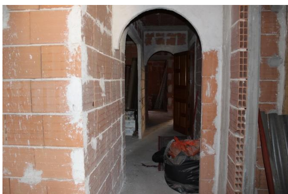
Vista del corridoio
