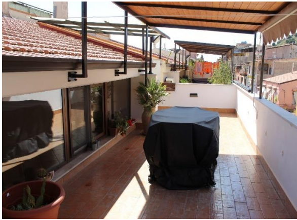
Vista della terrazza su via V.E., coperta in parte
