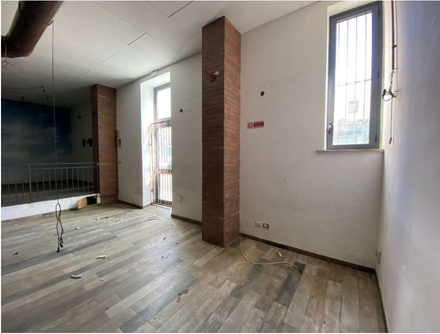
Figura 12: Vista degli interni e delle vie di uscita su spazio interno
