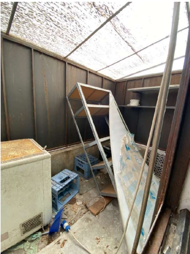
Figura 13: Vista da interno di spazio veranda esterna
