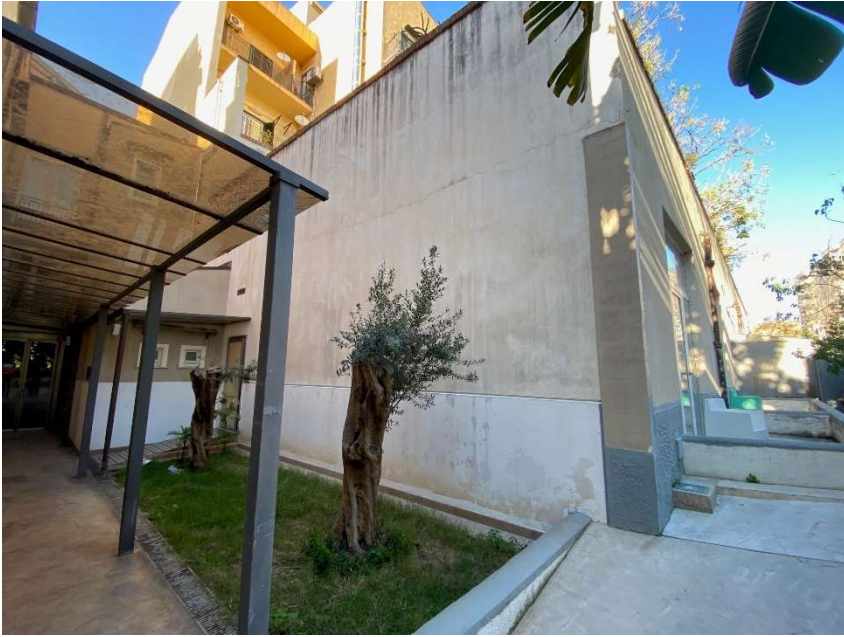
Figura 4: Foto prospetto laterale
