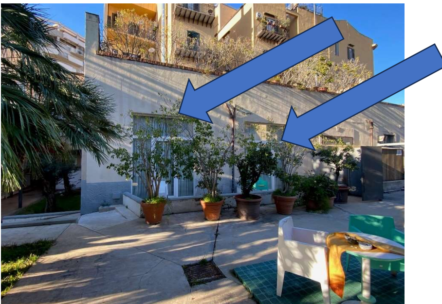
Figura 3: Ingresso Via delle Prigioni n 52 interni 3 e 4
