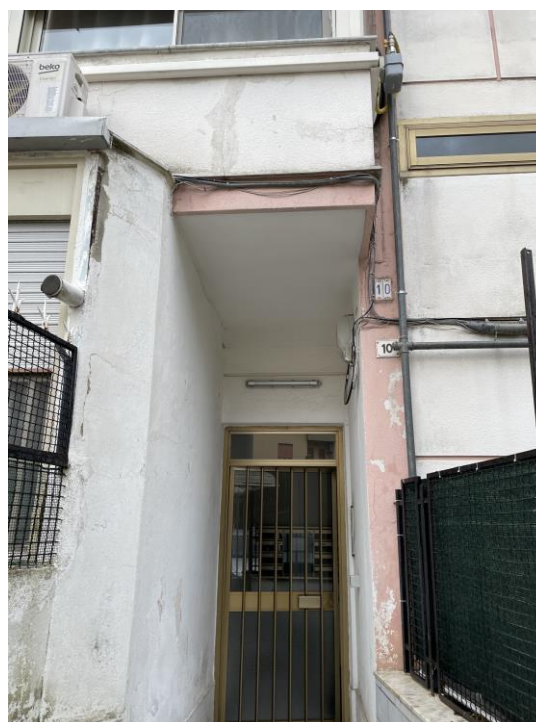
Foto 3 – Il portoncino di ingresso
