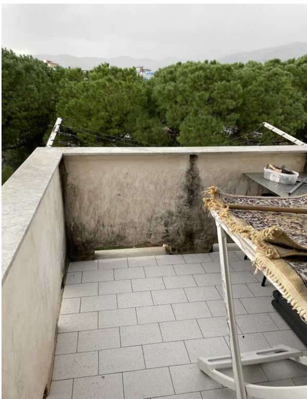
Foto 14 – Il balcone sul prospetto posteriore, con evidenti macchie dovute a infiltrazioni d'acqua Foto 15 – Foto dal balcone del prospetto sul retro
