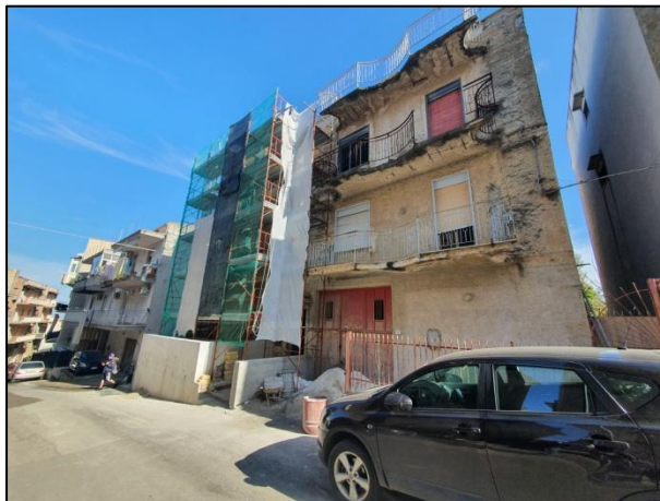
Foto 1- Prospetto del fabbricato
