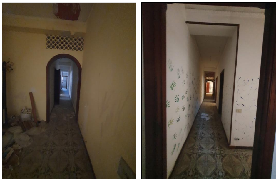
Foto 6 -7 – corridoio di disimpegno
