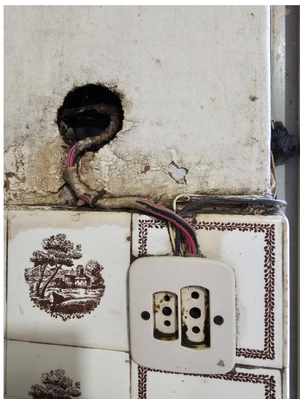
Foto 19-20-21 vetustà dell'impianto elettrico e della struttura
