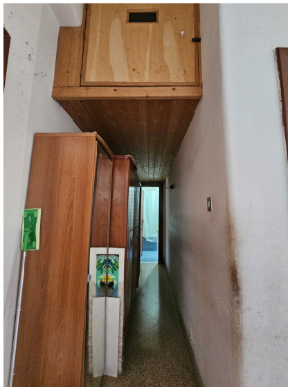
Foto 23 corridoio verso le altre camere
