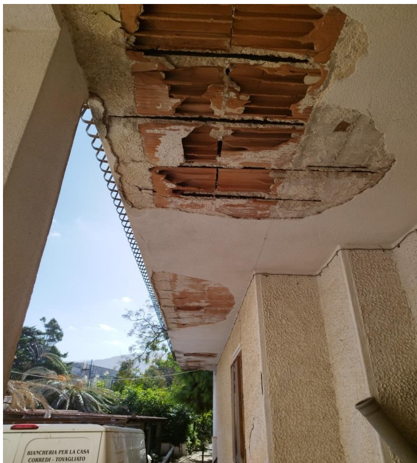
Sotto balcone di primo piano - lato interno
