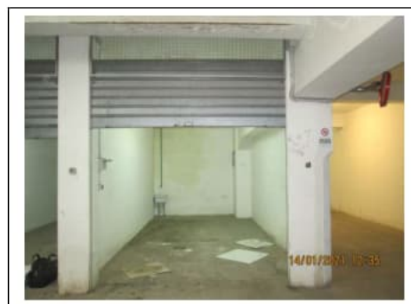
Fig. 25. Primo piano seminterrato. Box auto pignorato identificato al sub. 32
