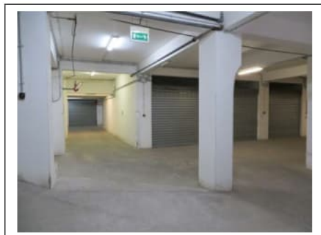
Fig. 16. Primo piano seminterrato. Box auto e corsie di manovra in prossimità della rampa di ingresso dal civico 38
