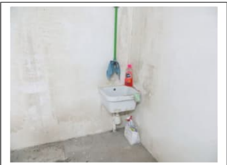
Fig. 30. Primo piano seminterrato. Box auto pignorato identificato al sub. 39. Piletta con punto acqua
