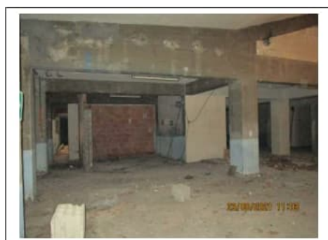
Fig. 41. Secondo piano scantinato. Zona sotto la rampa e blocco ascensori
