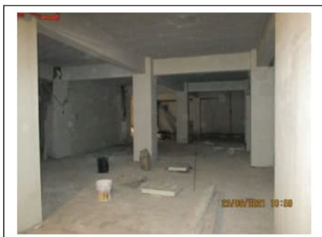
Fig. 40. Secondo piano scantinato. Corsie di transito
