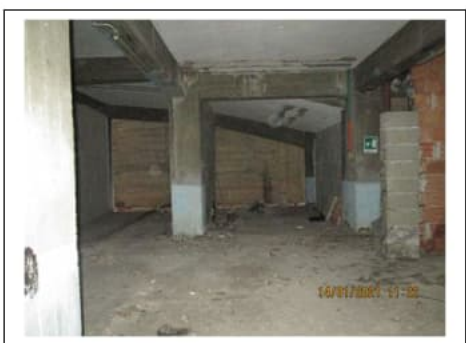
Fig. 44. Secondo piano scantinato. Zona sotto la rampa
