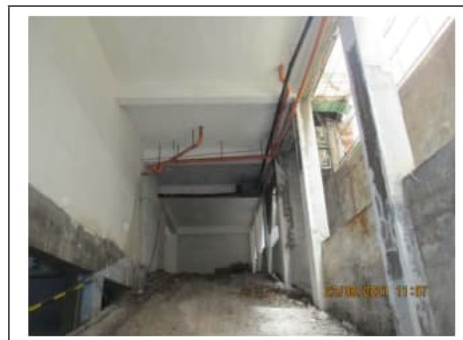
Fig. 27. Rampa del secondo piano scantinato con ingresso dal civico n. 20 di via Villa Heloise
