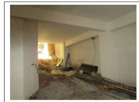
Fig. 23. Rampa del secondo piano scantinato con ingresso dal civico n. 20 di via Villa Heloise
