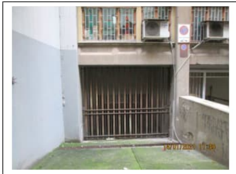
Fig. 20. Ingresso alla rampa del secondo piano scantinato dal civico n. 20 di via Villa Heloise
