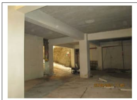
Fig. 36. Secondo piano scantinato, corsia di transito
