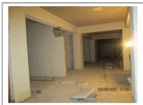
Fig. 38. Secondo piano scantinato, corsia di transito
