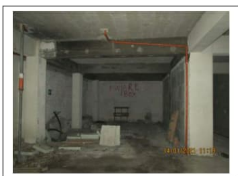
Fig. 34. Secondo piano scantinato. Box auto antistante la rampa di accesso
