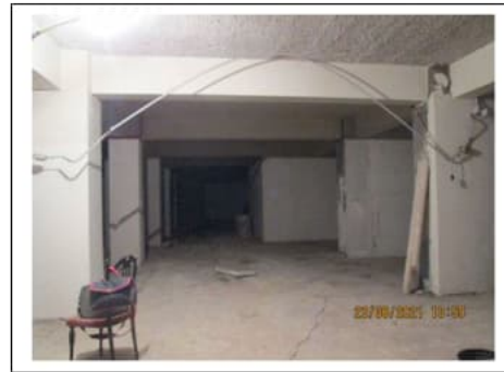
Fig. 49. Secondo piano scantinato. Corsia di manovra
