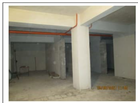
Fig. 37. Secondo piano scantinato, corsia di transito
