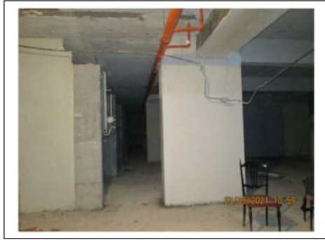
Fig. 48. Secondo piano scantinato. Corridoio di accesso ai box
