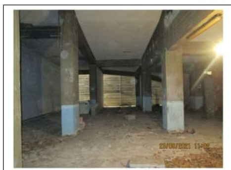
Fig. 45. Secondo piano scantinato. Zona sotto la rampa
