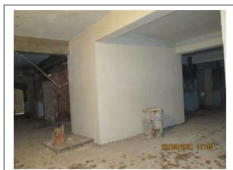
Fig. 47. Secondo piano scantinato. Blocco ascensori
