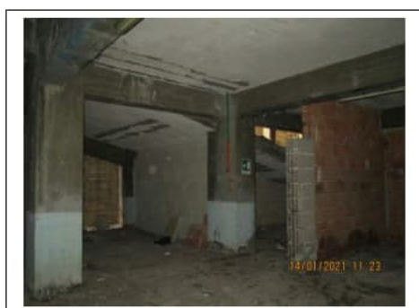
Fig. 43. Secondo piano scantinato. Zona sotto la rampa
