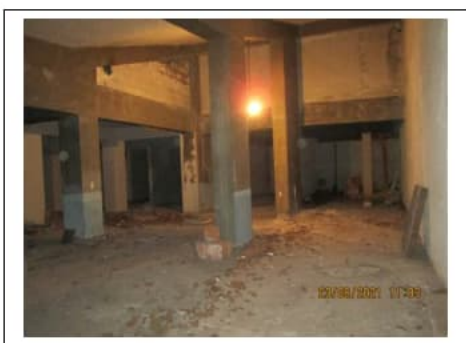
Fig. 42. Secondo piano scantinato. Zona sotto la rampa
