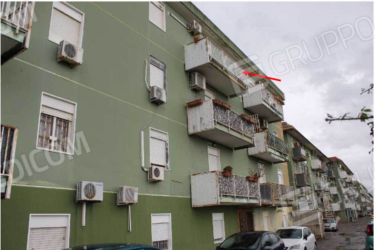
Fronte principale della scala A, a confine con area a parcheggio condominiale – Vista verso il cancello scorrevole di accesso
