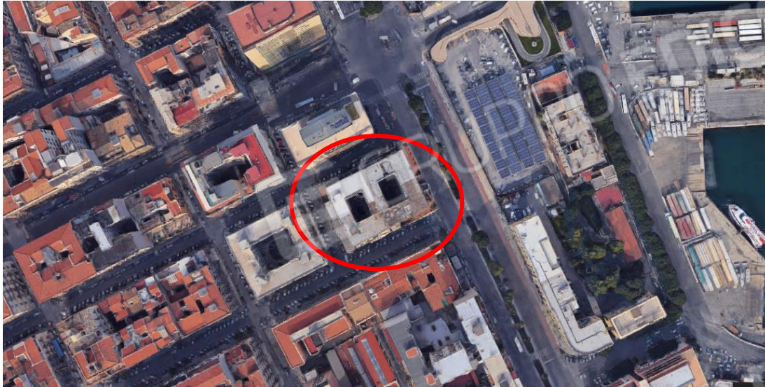
Foto 3: vista dall'alto dell'edificio individuato toponomasticamente dal civico 2/A della via Ammiraglio Gravina, in cui insiste l'appartamento staggito, identificato catastalmente, nel foglio 120 di Palermo, dalla particella 422 sub. 37; la foto mostra il contesto di inserimento
