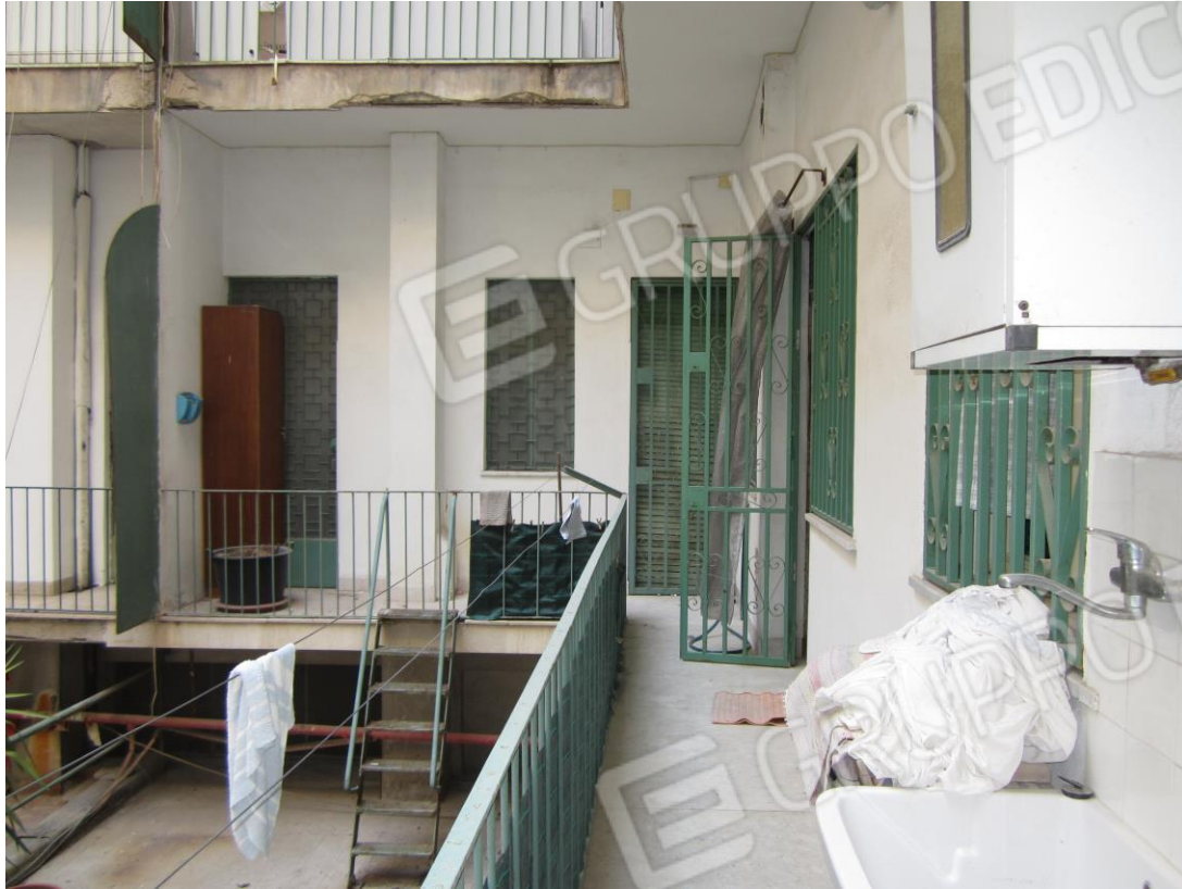
Foto 27: il balcone su cui si affacciano i due w.c., cui si accede dalla cucina e dall'ingresso
