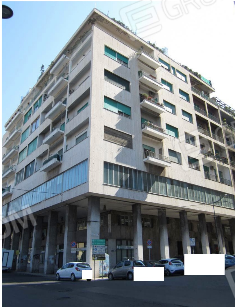
Foto 4: panoramica, dalla via F.sco Crispi, dell'edificio in cui al secondo piano insiste l'appartamento staggito,
