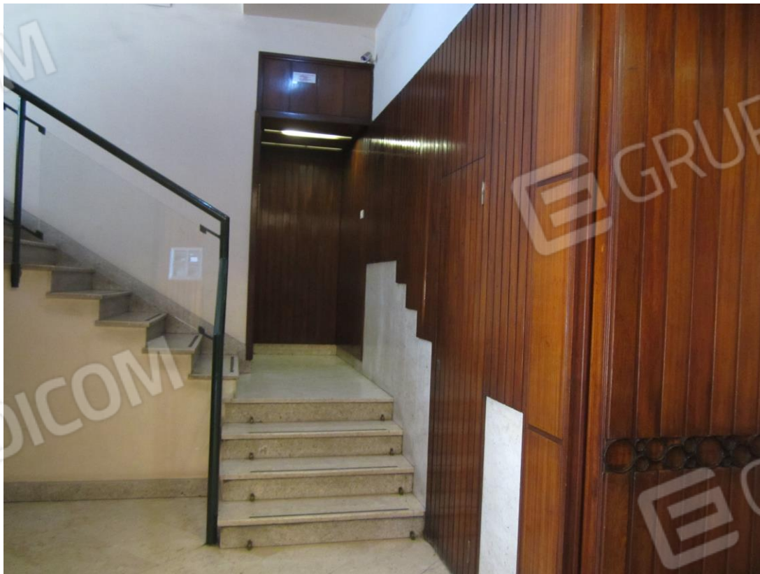
Foto 6: l'androne dell'edificio individuato toponomasticamente dal civico 1/C della via Principe di Belmonte, nel quale, al quarto piano, insiste l'appartamento pignorato
