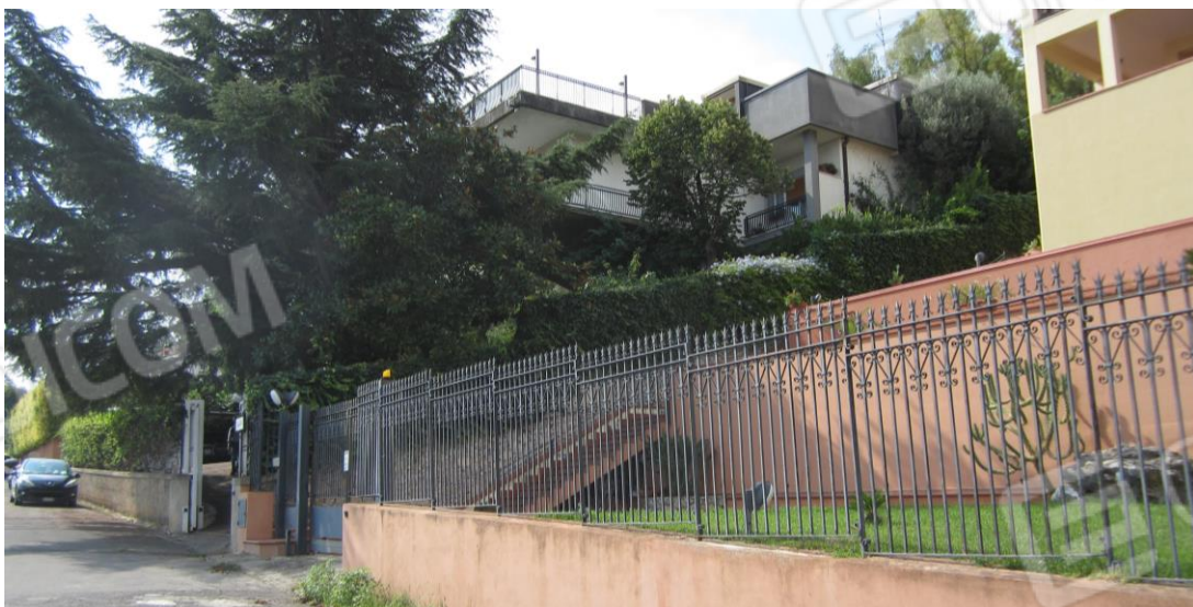
Foto 5: panoramica, dalla via Poggio Ridente, guardando verso monte, della villa identificata catastalmente, nel foglio 141 di Palermo, dalla particella 1034
