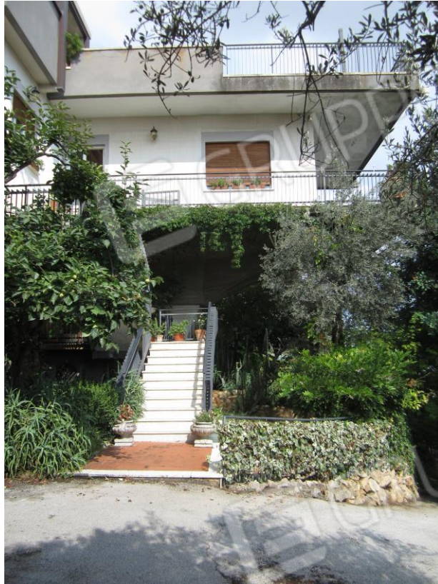
Foto 10: la scala che si diparte dallo slargo su cui si attesta il vialetto esterno e che consente di raggiungere il piano terra ed il primo piano della villa
