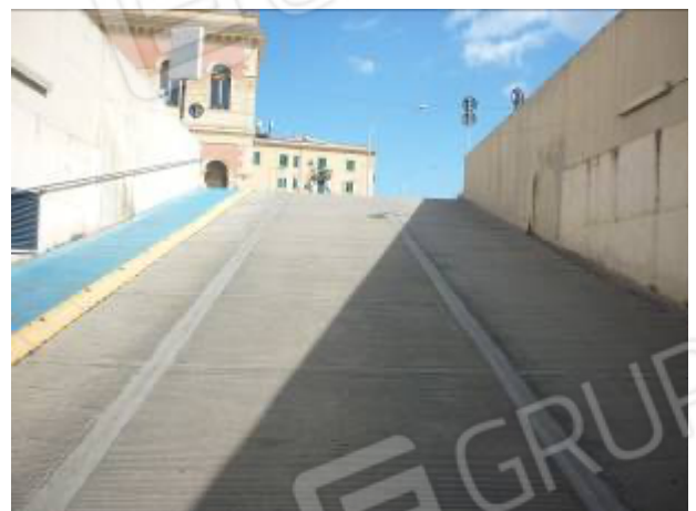
Foto n. 3 – Rampa di accesso al parcheggio
