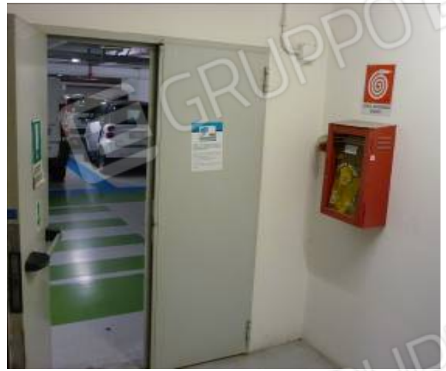
Foto n. 7 – Porta di accesso dal vano scala all'area parcheggio
