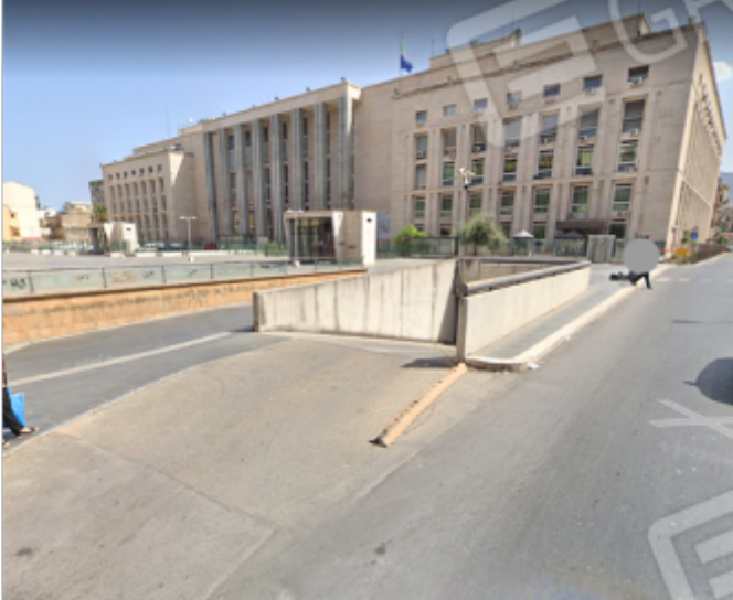
Foto n. 4 – Rampa di uscita dal parcheggio
