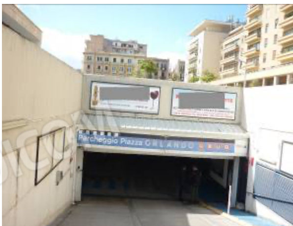
Foto n. 2 – Rampa di accesso al parcheggio
