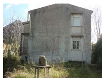
Foto 3 – Prospetto del fabbricato
