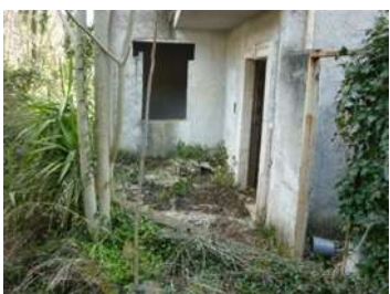
Foto 4 – Area antistante l'ingresso alla scala comune
