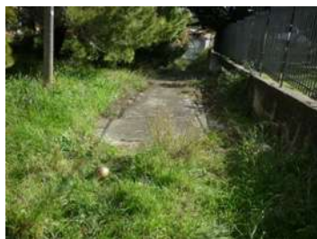
Foto 1 – Accesso dalla strada part. 321
