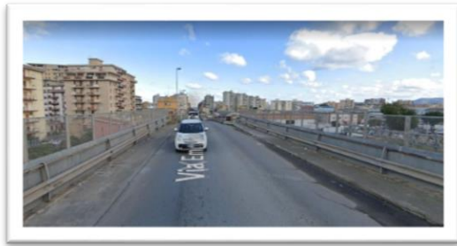
Ponte via Giafar sulla ferrovia
