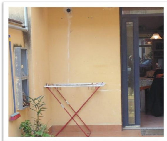
armadi esterni dove sono alloggiati i contatori elettrici alloggiamento (vuoto) contatore gas e predisposizione climatizzatore
