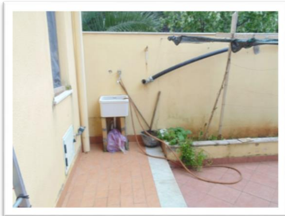
vista del terrazzino con punto acqua
