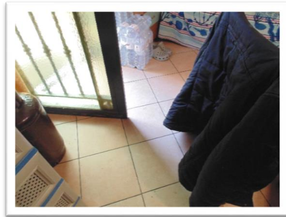
altra vista pavimentazione e particolare portoncino ingresso
