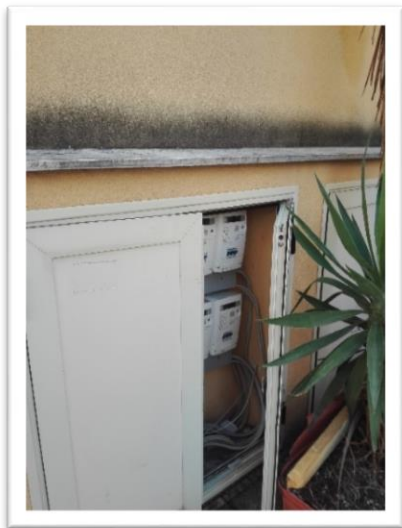
armadi esterni dove sono alloggiati i contatori elettrici alloggiamento (vuoto) contatore gas e predisposizione climatizzatore
