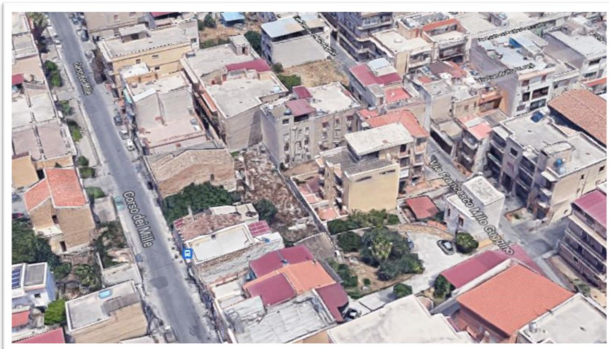
Vista del fabbricato fronte sx e retro
