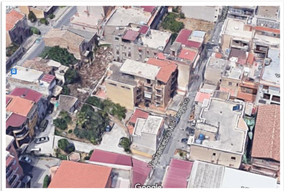
Vista del fabbricato fronte laterale sx
