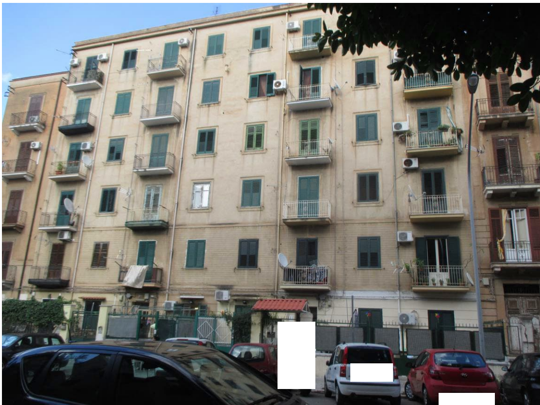
Foto 1: Prospetto del fabbricato su Via delle Cliniche, 14
