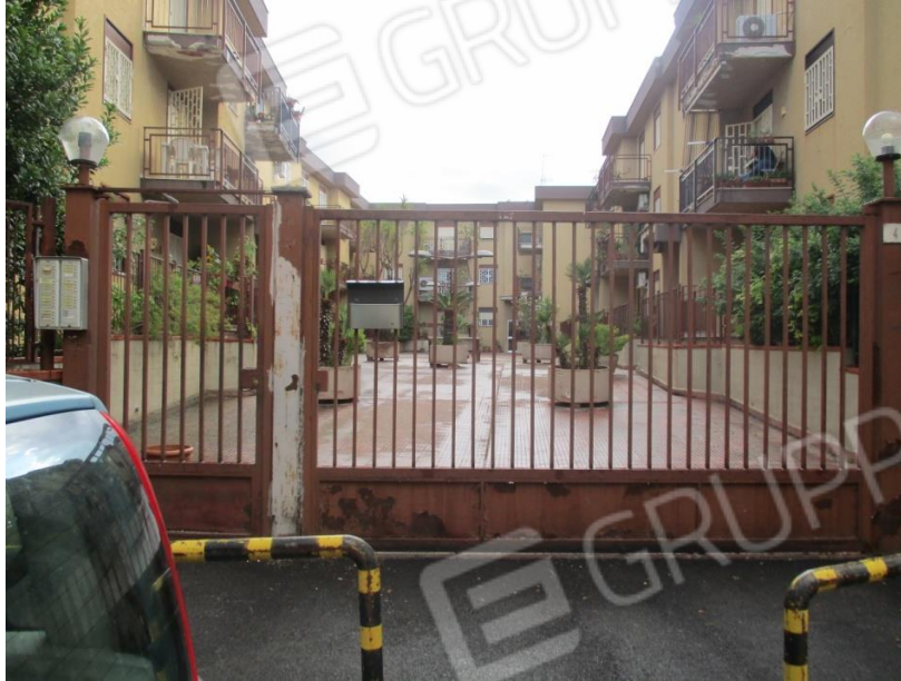
Foto 1 – Cannello di ingresso dalla via L. Vanvitelli n. 5
