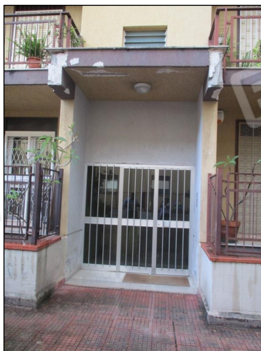
Foto 4 – Accesso alla scala B - Palazzina C
