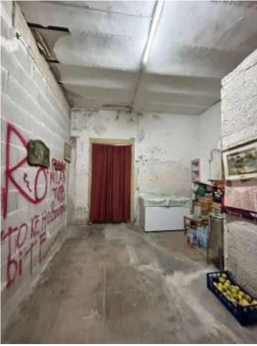
magazzino e w.c al piano terra
