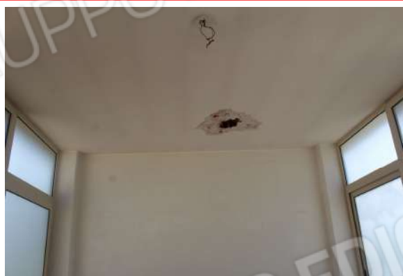
CM2: Intradosso solaio Vano 16.
