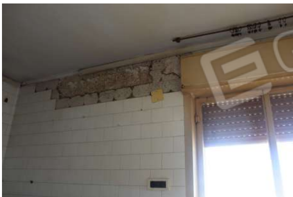
CM1: Rivestimento pareti Vano 7.
