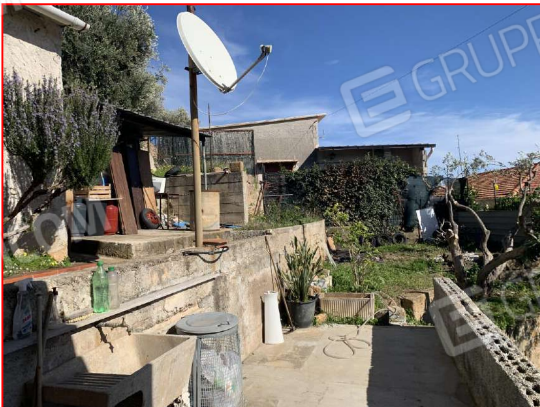
Foto n. 13 – Esterni del complesso immobiliare – piano terra
