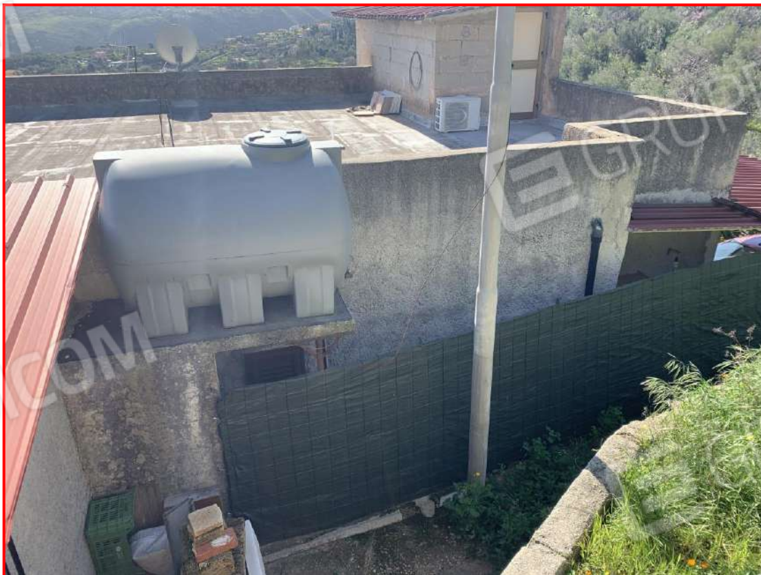
Foto n. 9 – Esterni del complesso immobiliare – vista dall'accesso condiviso– Prospetto Nord
