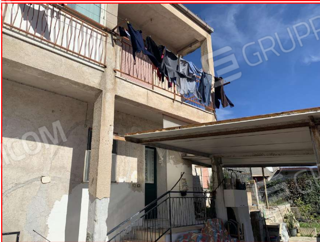
Foto n. 5 -Esterni del complesso immobiliare – Prospetto Sud
