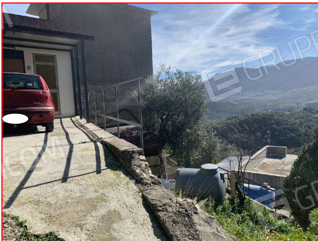
Foto n. 7 – Esterni del complesso immobiliare – vista da strada interpoderale – Prospetto Ovest
