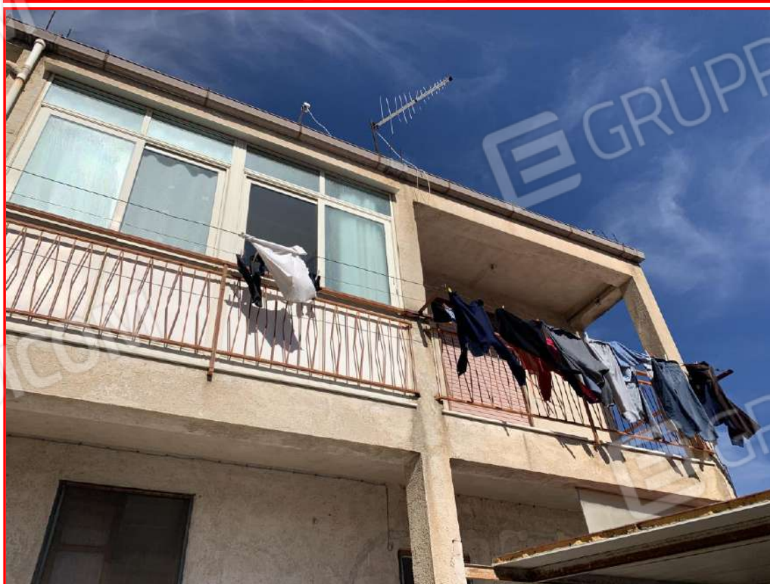
Foto n. 6 – Esterni del complesso immobiliare – Piani superiori prospetto Sud.
