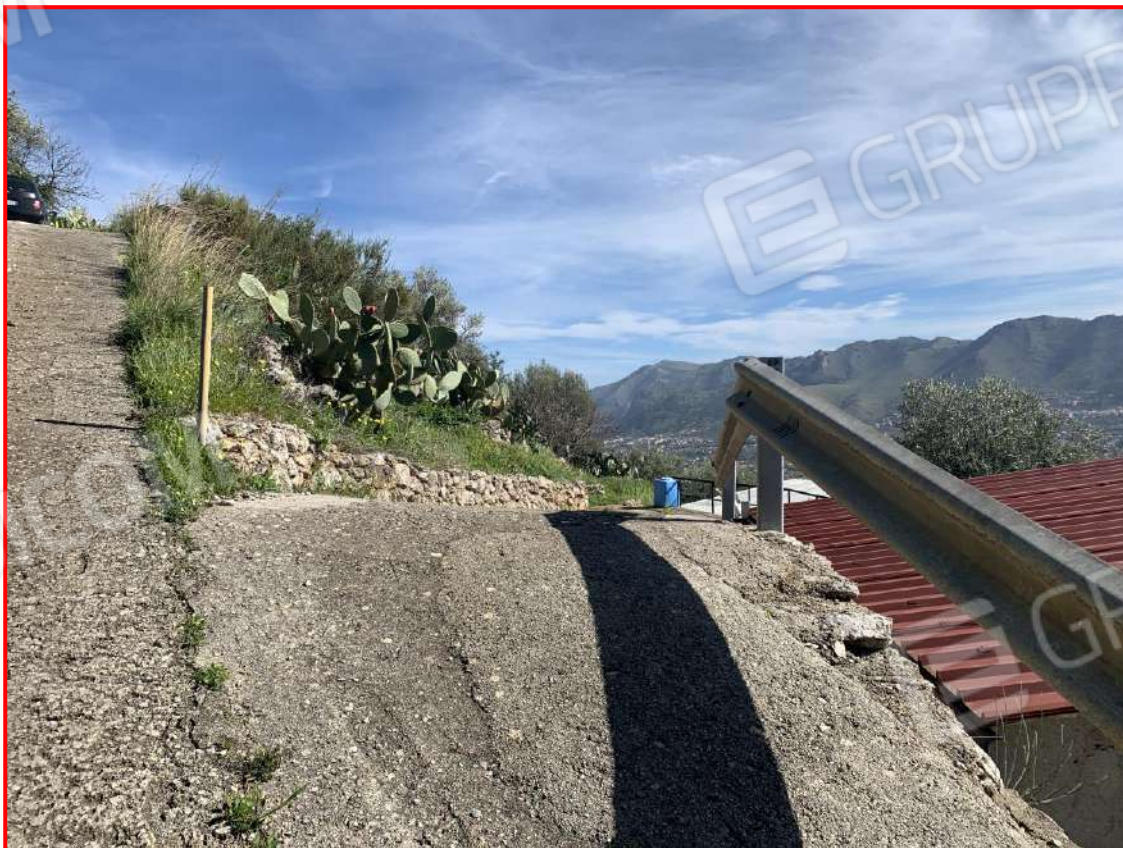
Foto n. 4 - Esterni del complesso immobiliare - Accesso al Piano Terzo e accesso indiviso con proprietà
