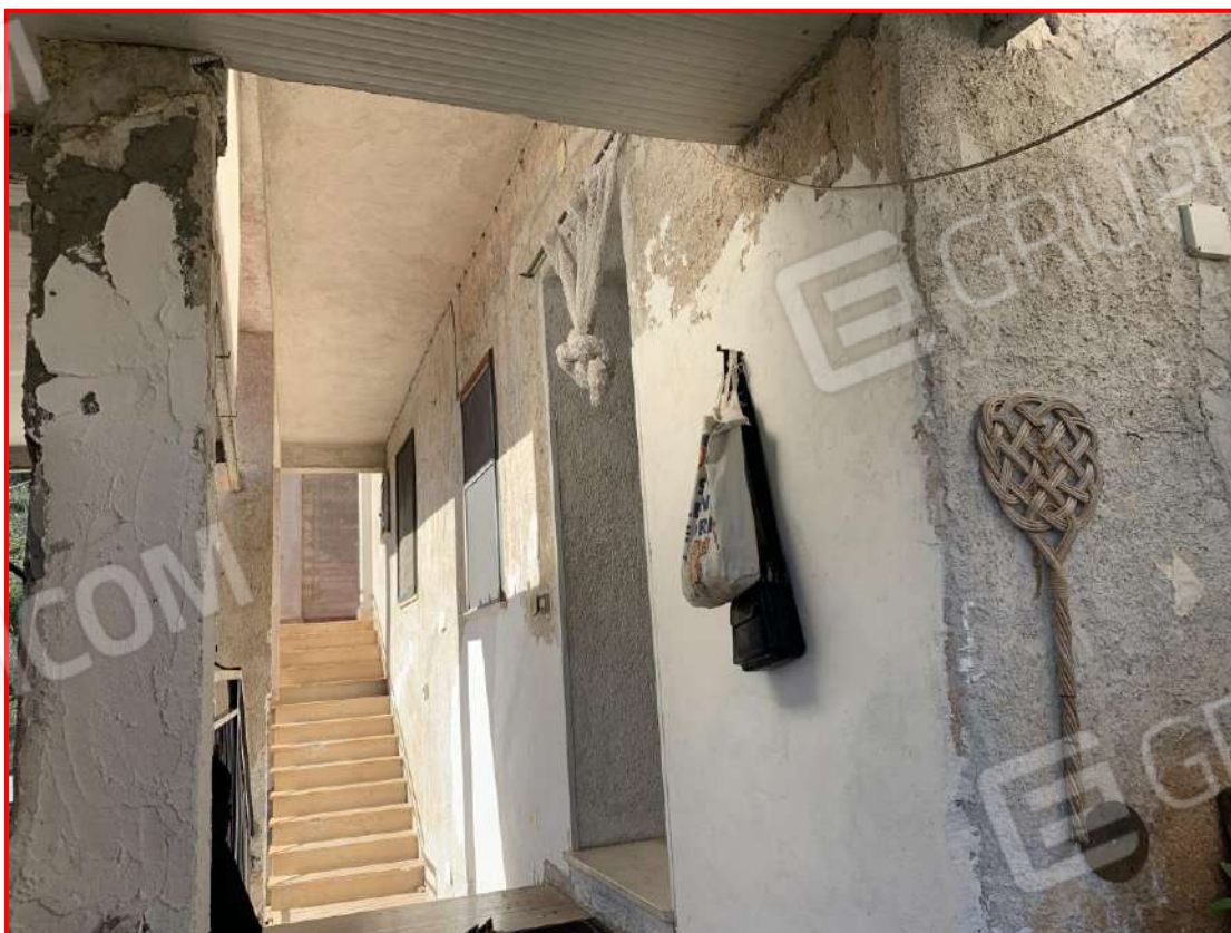
Foto n. 4 – Esterni dell'unità immobiliare – vista dal portico sul prospetto Sud – Accesso al vano scala dal Piano Terra
