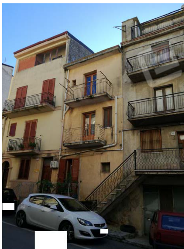
Foto n. 2 Vista prospetto su via Popolo
