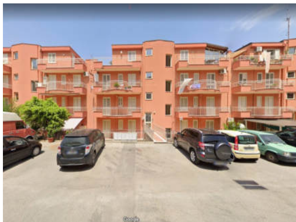
Prospetto su Via Buttitta
