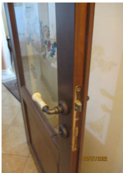
Particolare di una porta
