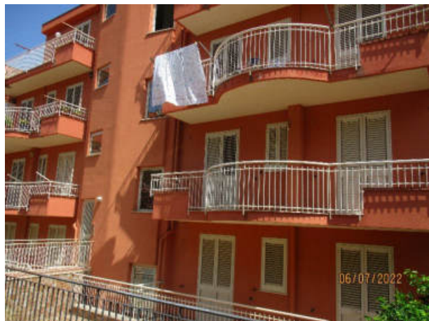
Prospetto su Via Buttitta
