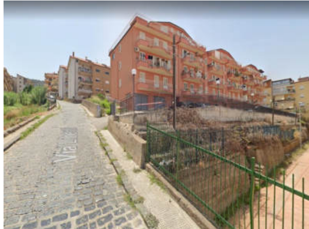
Veduta dell'edificio dalla Via Libertà
