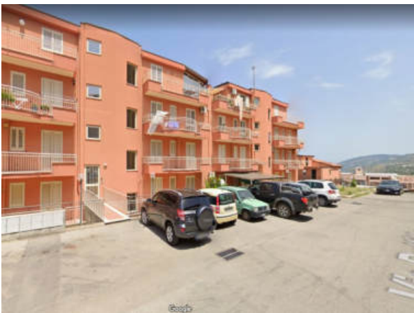
Veduta del prospetto (lato monte) sulla Via Buttitta
