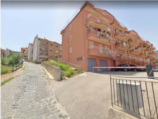
Veduta del prospetto (lato mare) sulla corte/parcheggio
