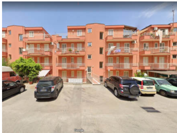
Prospetto lato monte dell'edificio su via Buttitta
