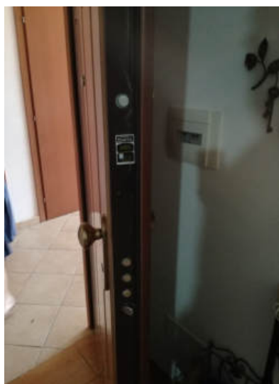
Particolare porta di ingresso
