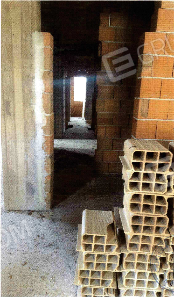
FOTO N° 4 – PARTICOLARE DI INTERNO
