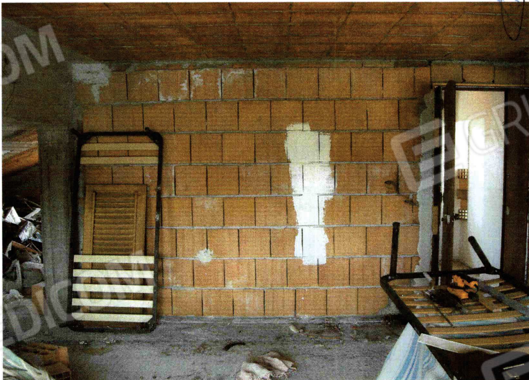
FOTO N. 4 – INTERNO SOTTOTETTO E PORTA DI INGRESSO
