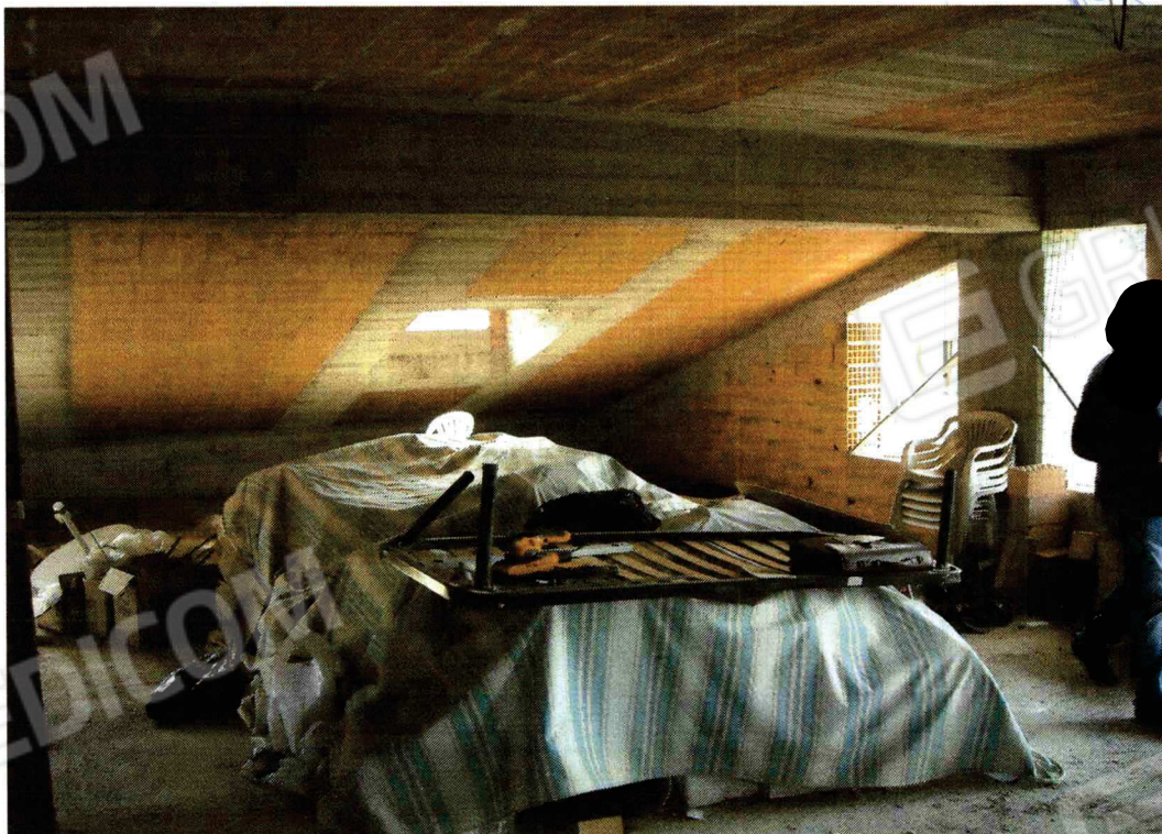
FOTO N. 6 – INTERNO SOTTOFALDA LATO SUD OVEST
