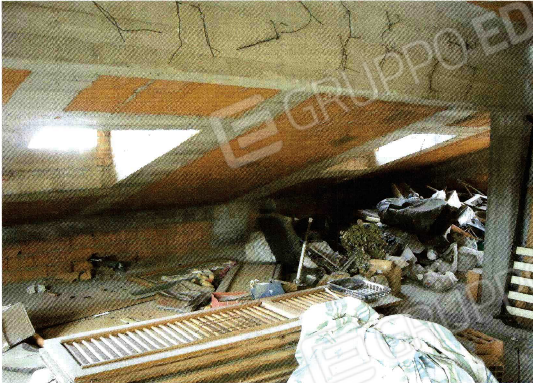
FOTO N. 5 – INTERNO SOTTOFALDA LATO NORD
