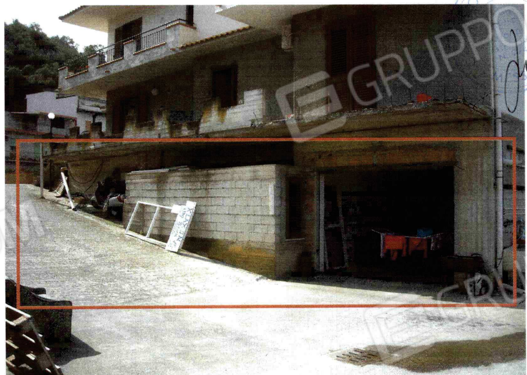
FOTO N. 2 - PIANO SEMINTERRATO PROSPETTO EST - CONTORNATO
