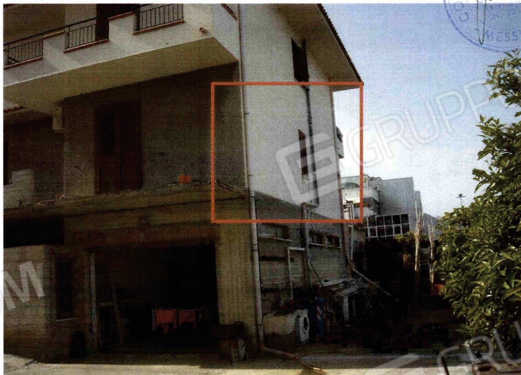
FOTO N. 4 - PIANO TERRA PROSPETTO NORD - CONTORNATO
