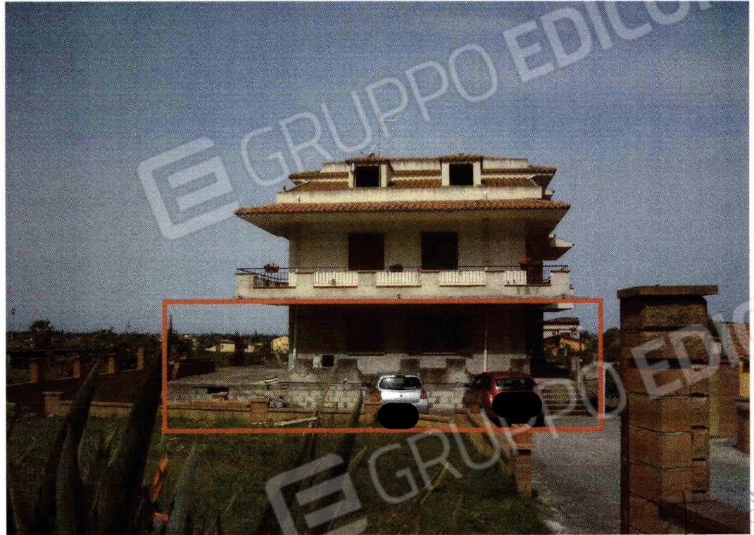
FOTO N. 1 – PIANO TERRA PROSPETTO SUD - CONTORNATO
