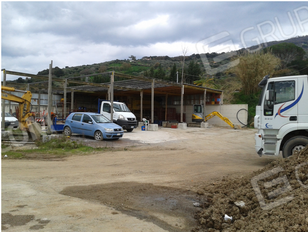
Piazzale con tettoia in struttura precaria
