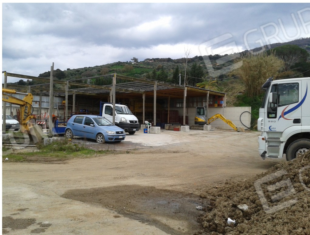
Piazzale con tettoia in struttura precaria
