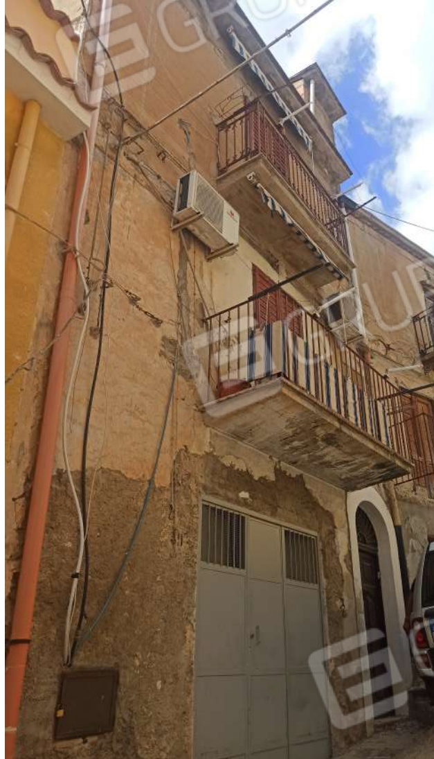
Prospetto da Via Cordicella 51
