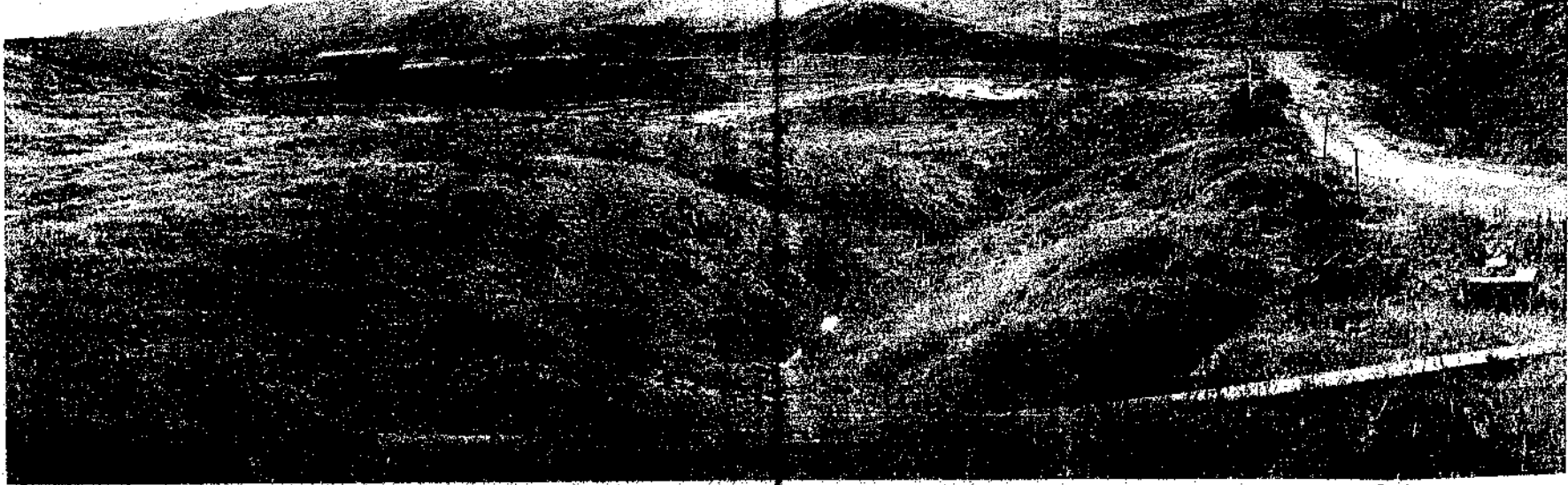
Foto : Direzione Ovest
