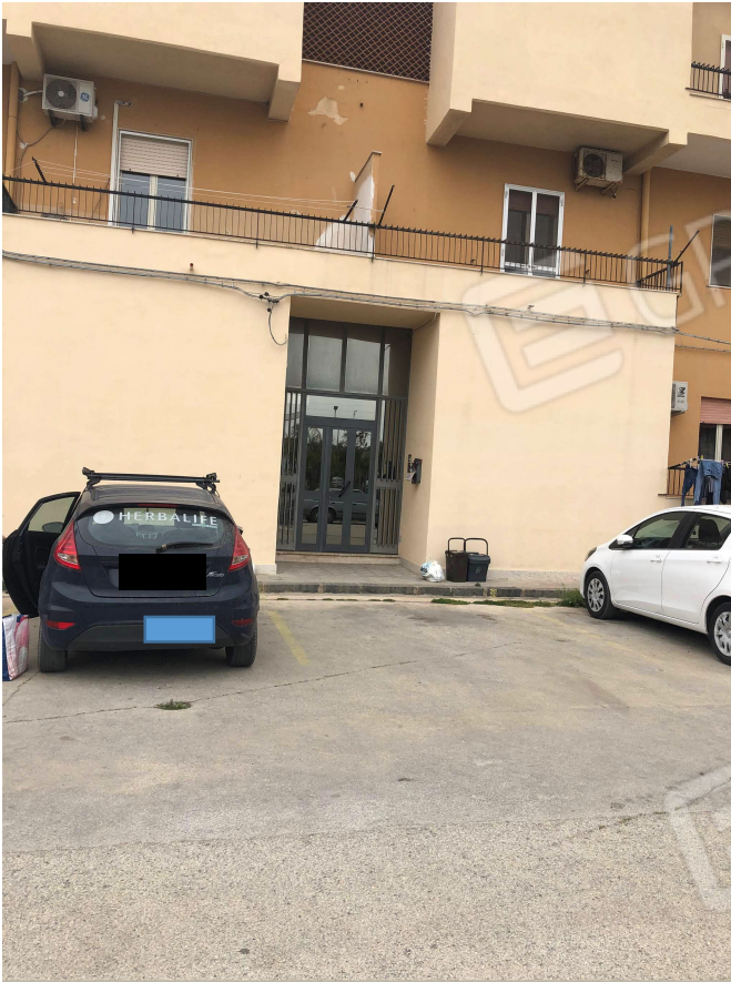
Foto 3: Vista del portone di ingresso comune.
