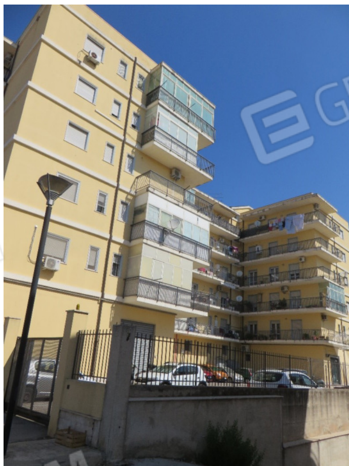
ESTERNI VIA CRISPI, 204 - SUD - EST
