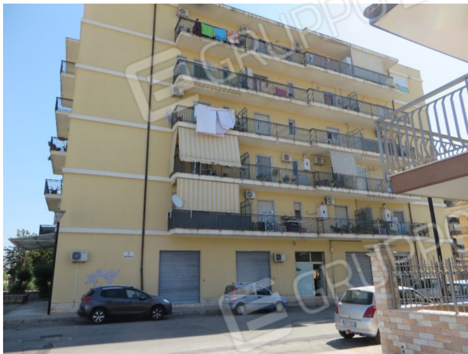
ESTERNI VIA CRISPI, 204 - SUD-OVEST
