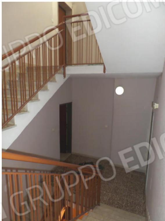
Foto n° 5. Vano Scala – Piano 2°
