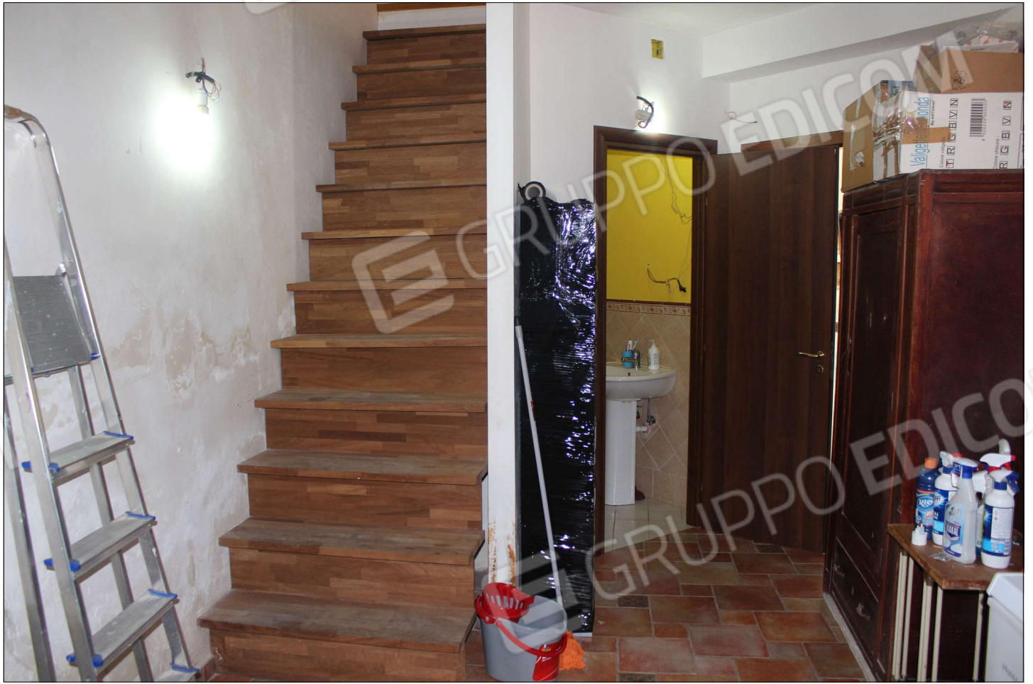
N.11 Vista vano scala-bagno
