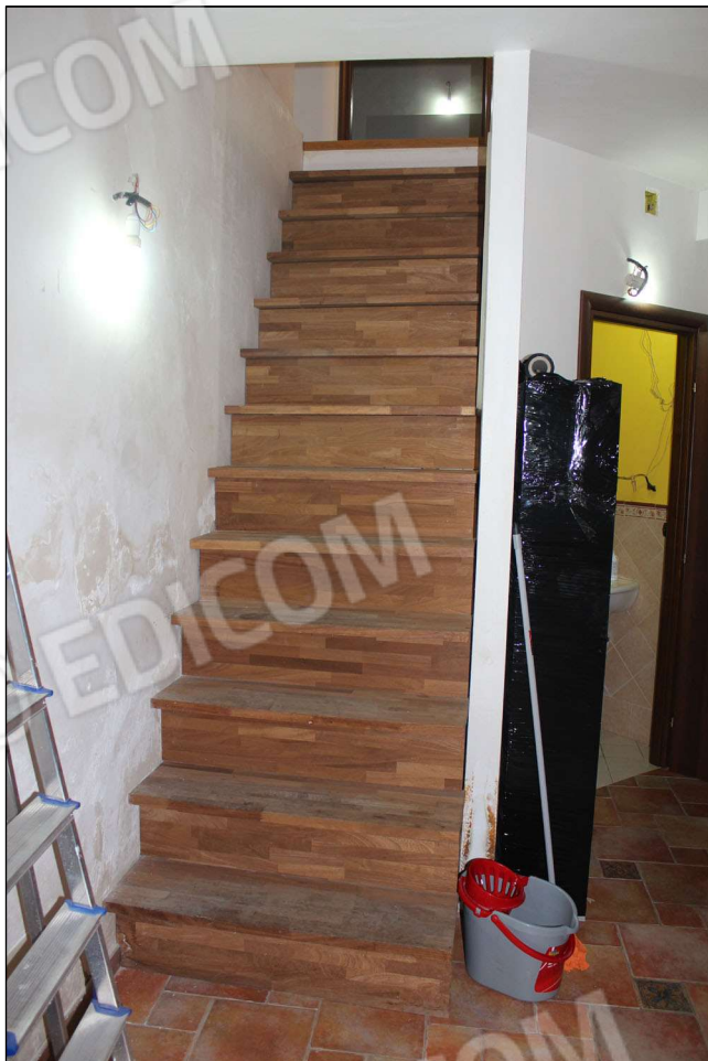
N.12 Vista vano scala
