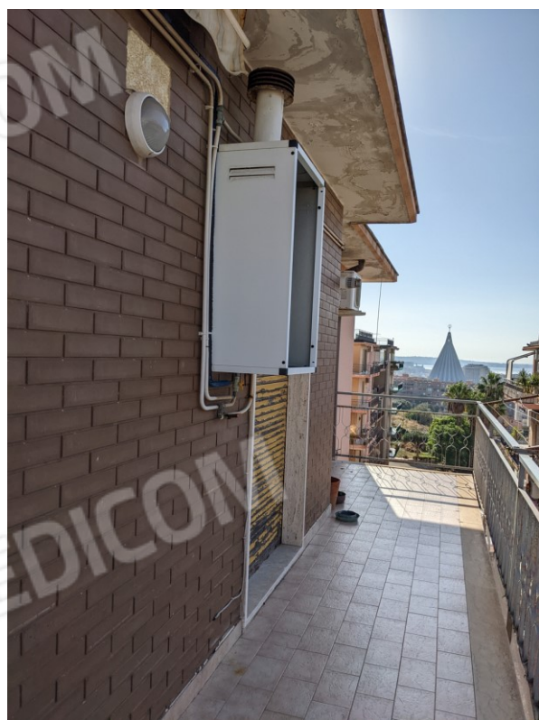
Balcone lato ovest
